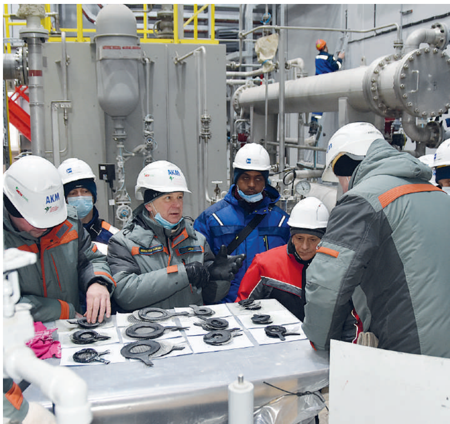
Руководство компании «Метафракс» и строящегося завода АКМ в деталях оценивают качество монтажа оборудования
