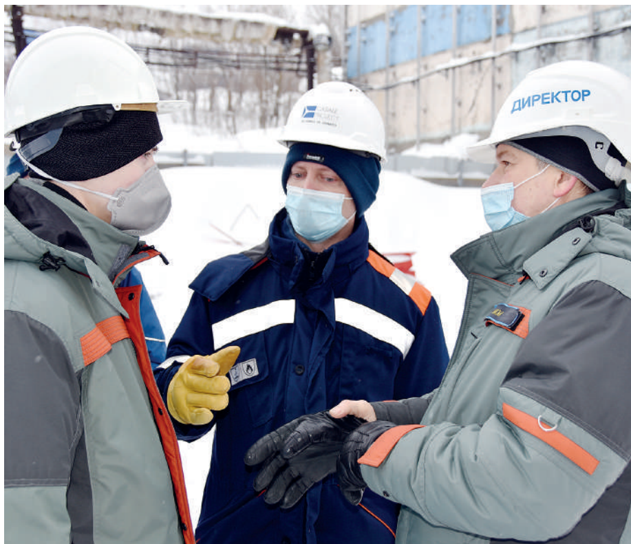
Работы на объекте контролирует директор строящегося завода Александр ЛЫСОВ (справа) в контакте с представителями компании – лицензиара
