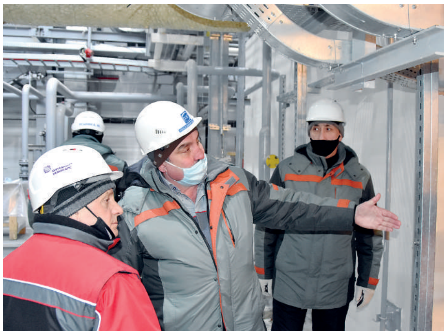
Руководитель проекта возведения комплекса – гендиректор «Метафракса» Владимир ДАУТ (слева) лично осматривает каждый объект, принимая доклады генподрядчиков. Технический директор компании «УЭС» Анатолий МИНАКОВ докладывает о состоянии предПНР на компрессоре азота
