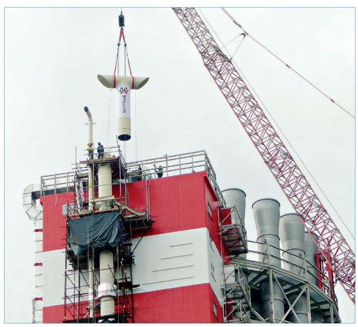
На стройплощадке завершена уникальная техническая операция по монтажу двух вентиляционных труб (свеч) на башне приллирования производства карбамида.
