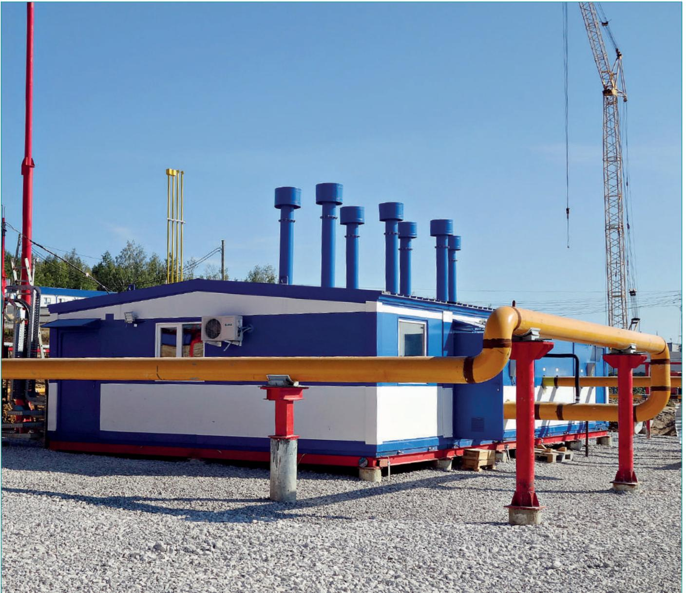
На стройплощадке произошло знаковое событие: в работу введён коммерческий узел учёта газа (КУУГ, на фото). Он будет учитывать расход природного газа, используемого в технологических процессах на производстве метанола и на установках комплекса.
