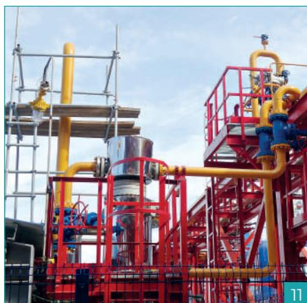
**Установка КУУГ была предусмотрена в рамках технического перевооружения газопровода высокого давления с пунктом замера расхода газа (ПЗРГ) в связи с расширением производственных площадей ПАО «Метафракс Кемикалс» и увеличением потребления природного газа.**
