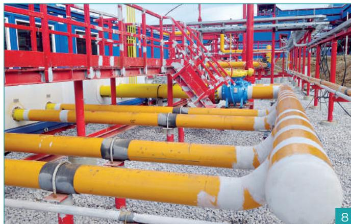
**Коммерческий узел учета расхода газа (КУУГ) входит в состав химического комплекса по производству метанола, аммиака, карбамида, мелamina и расположен на территории завода АКМ.**
