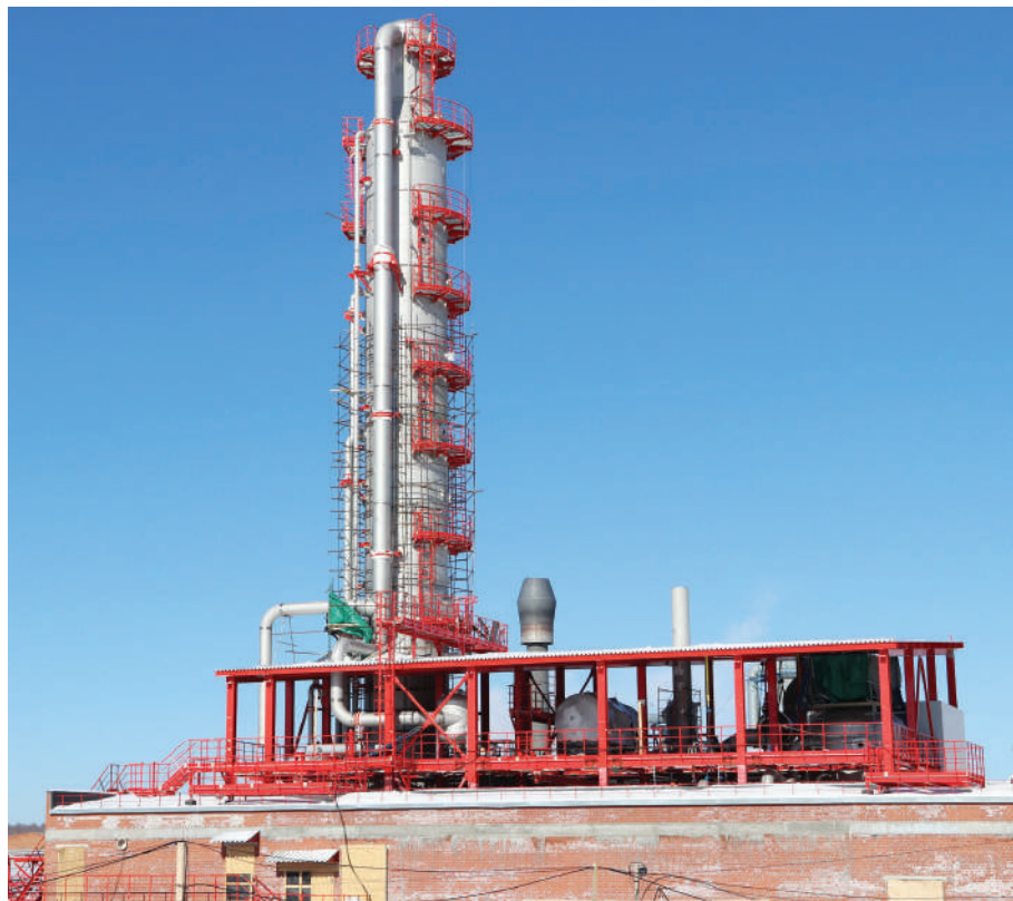
Так выглядела установка КФ-3 в марте этого года. Строительство агрегата вело ООО «Алтэкс-Строй» ускоренными темпами без нарушения качества.
