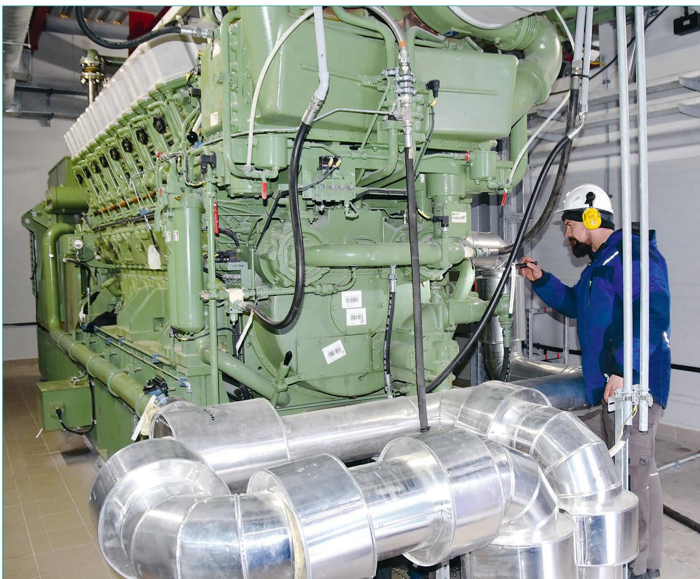
На стройплощадке комплекса под нагрузкой успешно испытана и проверена работоспособность электрического генератора производства компании MARGEN с дизельным приводом, установленного в здании центрального пульта управления.
