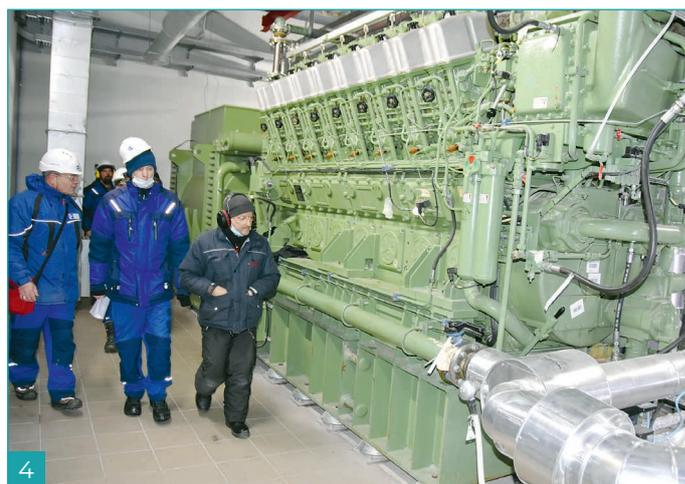
ровать и проверить, что устройство запустилось, вышло в отведённое время на рабочий режим в готовности принять нагрузку аварийных потребителей. По итогам испытаний должно быть признано, что АДГ со всеми системами регулирования исправен и готов к эксплуатации».
