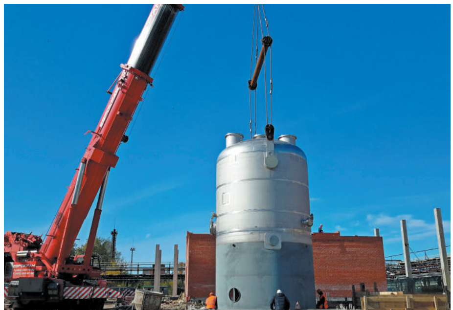
Строительство установки КФ-2
