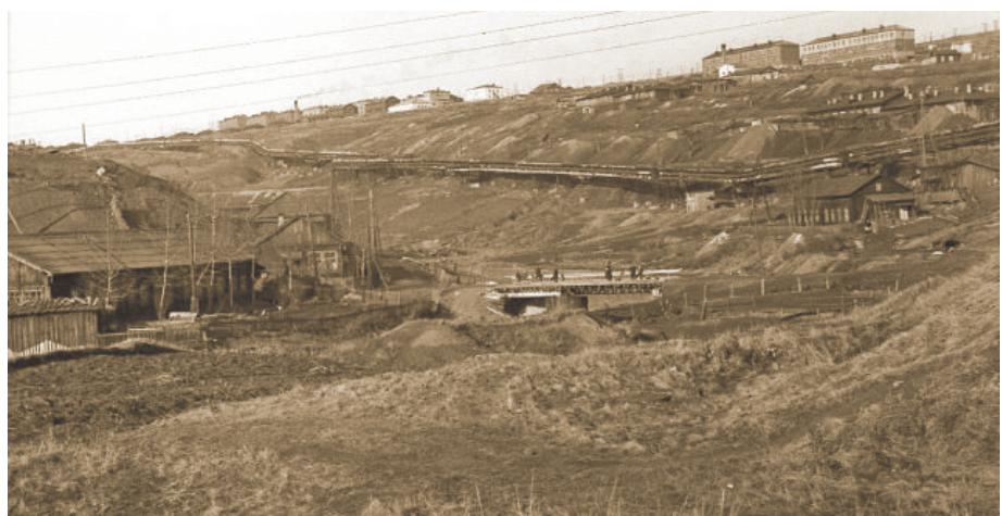
Паропровод от Кизеловской ГРЭС № 3.
