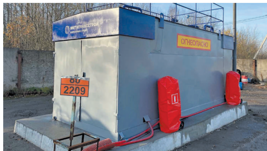
В автомобильном гараже смонтирована автозаправочная станция контейнерного типа с запасом топлива в 20 кубов. Техническая новинка, оформленная в корпоративном стиле, реконструирована для круглосуточного обслуживания водителей машин без участия оператора – в автоматическом режиме.
