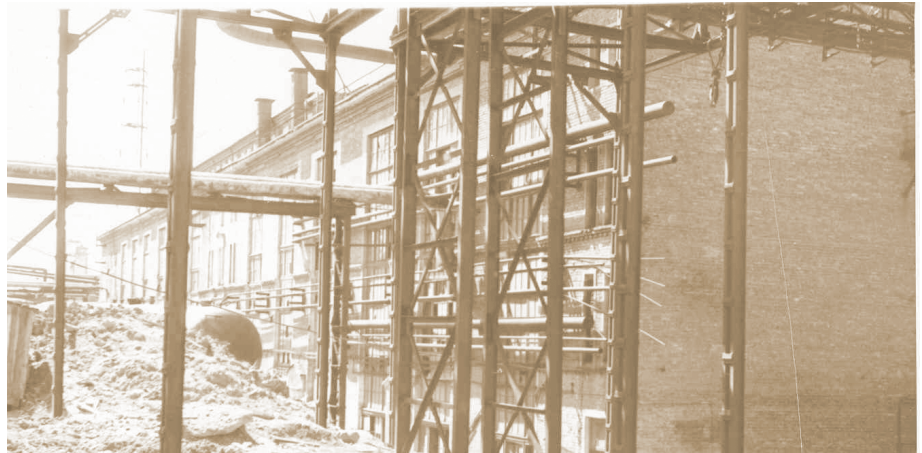
Строительство 455-го корпуса производства толуола.
