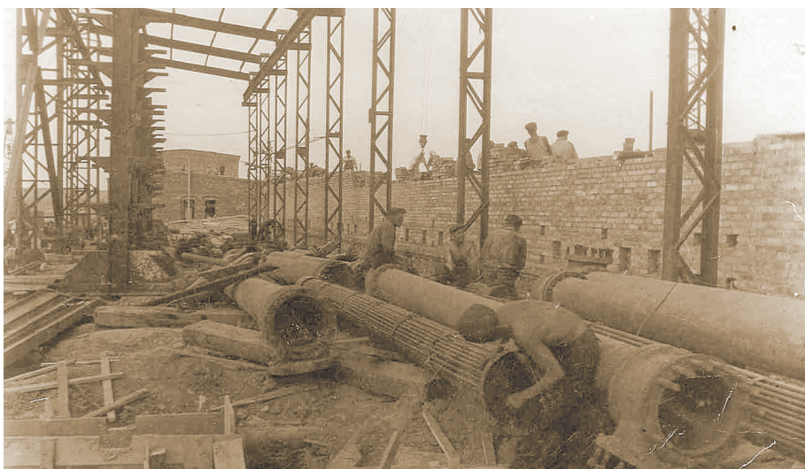
Строительство 458-го корпуса будущего производства толуола.
