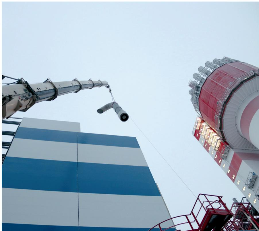
рукавных фильтров. Они в этот же день были смонтированы на основном корпусе рукавного фильтра осушенного меламина, поднятом еще в июне. Внутри этого фильтра и будут смонтированы 456 фильтровальных рукавов.
