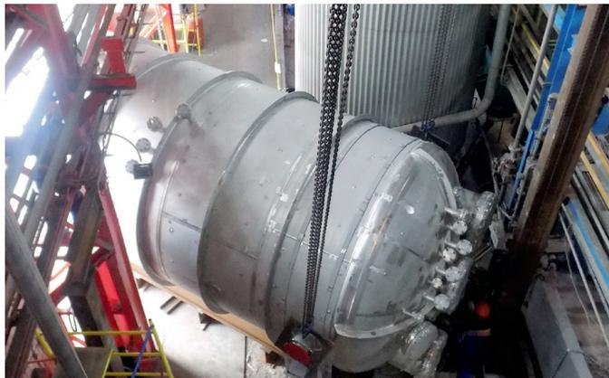
Компания «Метадинеа» на губахинской производственной площадке приступила к установке третьего реактора синтеза ФФ-смола. Реализация проекта по расширению мощностей позволит увеличить выпуск продукта на 37,5 тыс. тонн в год.
