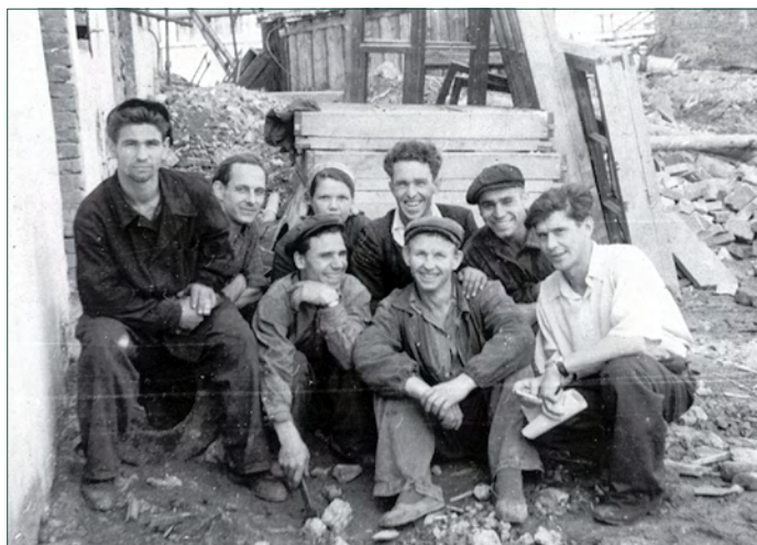
Бригада Половодов, компрессорная станция
