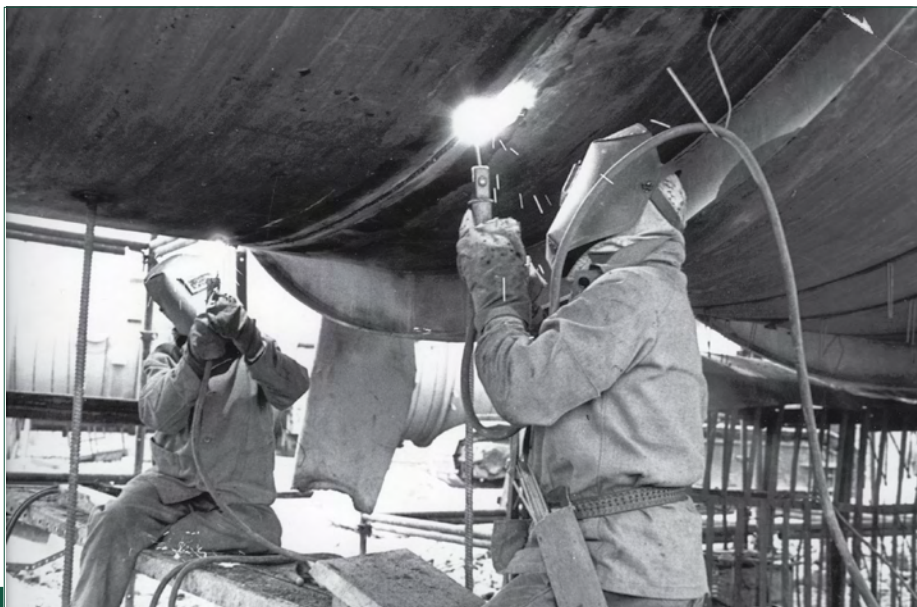
Английские сварщики на монтаже оборудования М-750
