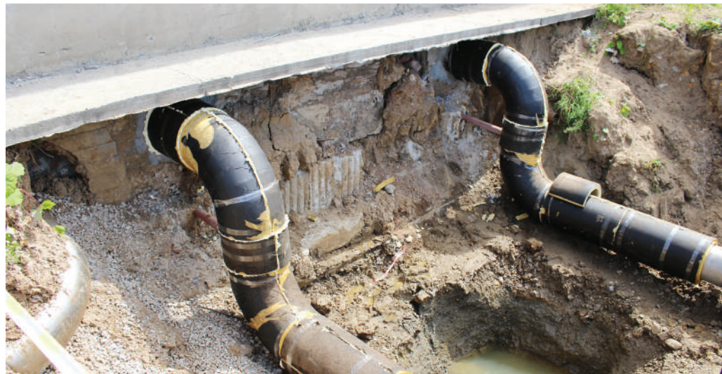
Завершен монтаж трубопроводов от вновь смонтированных насосов системы пожаротушения до границы проекта
