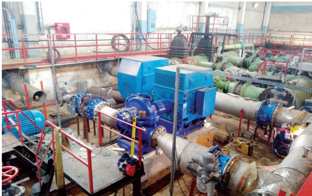
Идет монтаж насосных агрегатов для системы пожаротушения установки параформальдегида
