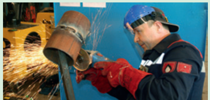
Сварщик Валерий ПОПОВ проводит обработку сварного шва
