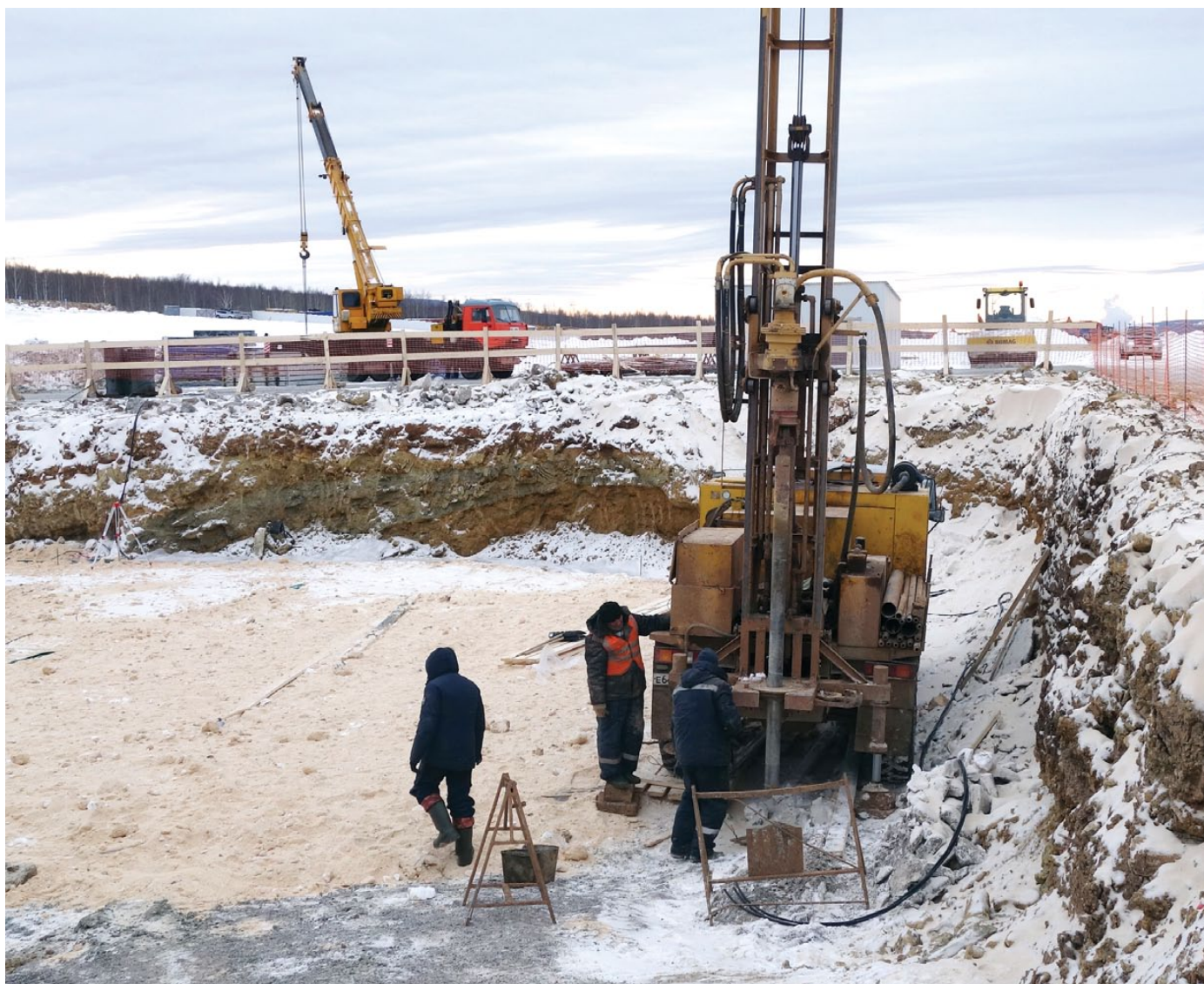
На площадке АКМ начались активные строительные работы
