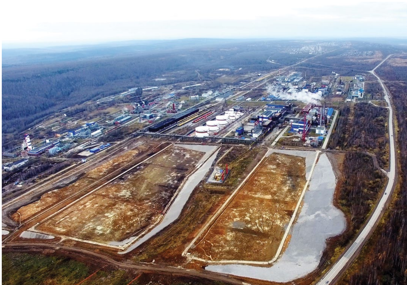
Площадка для нового комплекса АКМ готова
