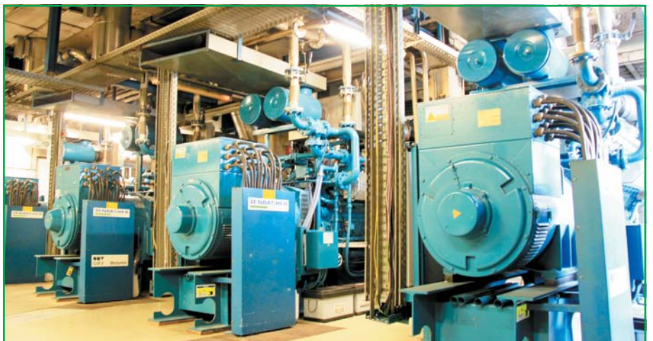
Im unternehmenseigenen Kraftwerk wird 3/4 des Stromes durch Verarbeitung des Schwachgases, das bei der Produktion von Formalin anfällt, selbst erzeugt. Auch die Prozesswärme in Form von Dampf wird als Energieträger genutzt.
