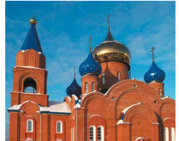
Ремонтные работы входных групп храма и цоколя, которыми также занимались специалисты «МетаТрансСтроя», были завершены еще в прошлом году.
