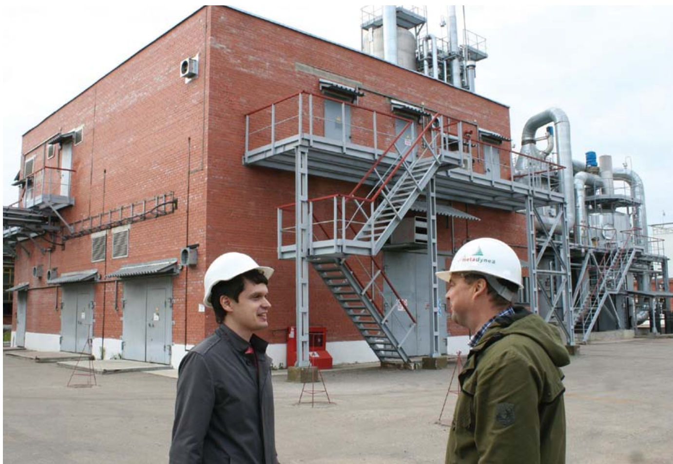
Технический директор компании «Метадинеа» (Орехово-Зуево) Вадим ГАЛКИН (справа) доволен качеством выполненных монтажных работ на оборудовании по производству 55-процентного формалина. Слева – ведущий менеджер Константин ВАГАНОВ.
