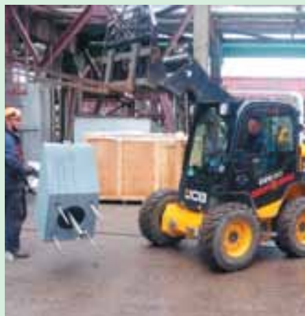
Работники подрядной организации поднимают новые горелки перед их установкой в печь.
