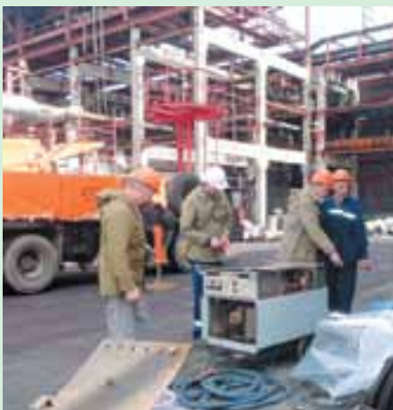
Идут ремонтные работы на блоке синтеза.
