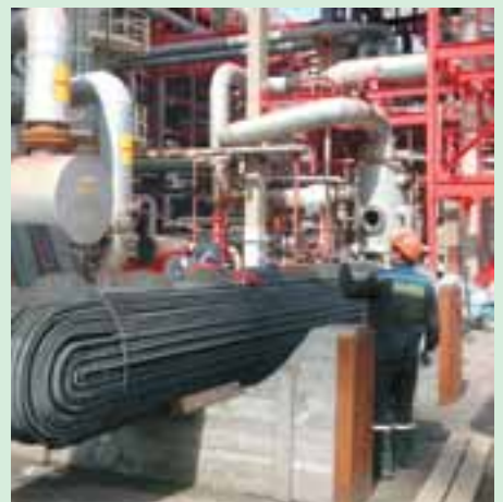
Работники ПОРОТЦ выполняют ремонт теплообменника отделения ректификации.
