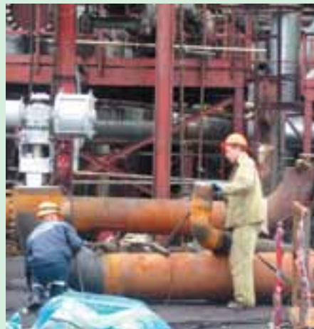
Работники подрядной компании «Мегастрой» производят обвязку трубопроводов.
