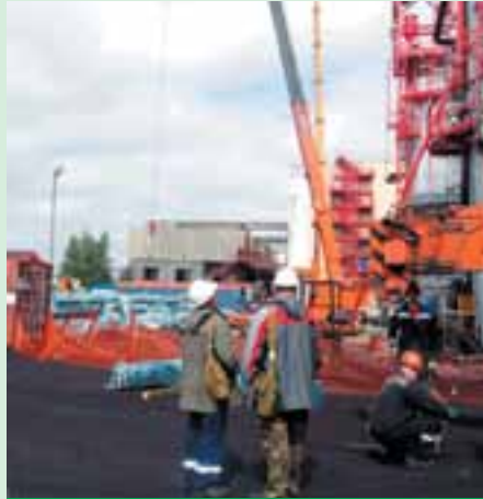
Работники транспортно-хозяйственного цеха налаживают подъемный кран.
