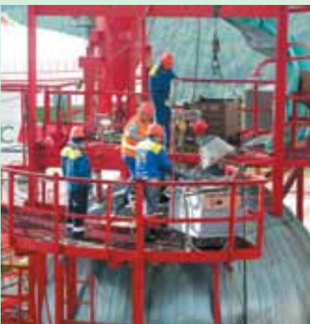
Сотрудники компании «АлДеСтрой» заняты ремонтными работами на реакторах синтеза.
