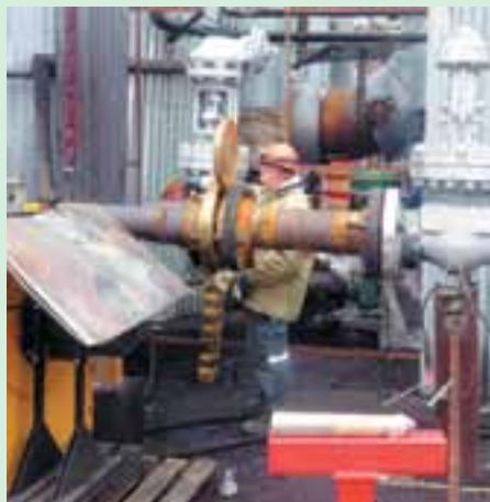
Производится замена арматуры и трубопровода на реакторе синтеза.
