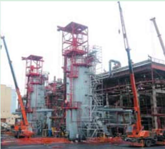
Производство метанола превратилось в большую ремонтную площадку.
