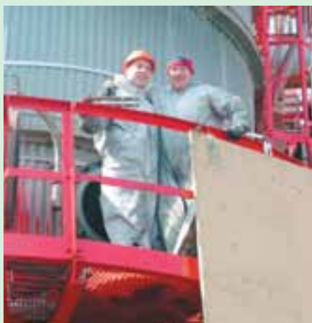
Работники ПОРОТЦ производят замену «тарелок» на колоннах ректификации.
