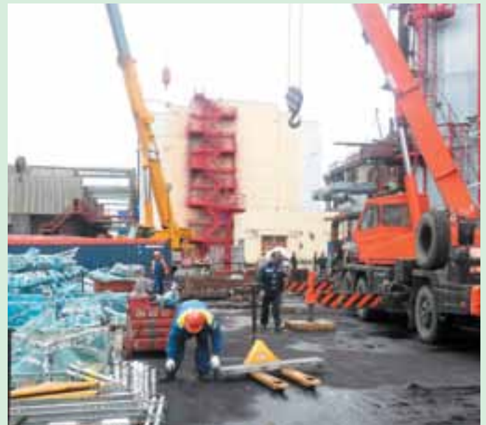
Идут подготовительные работы перед проведением реконструкции реактора.
