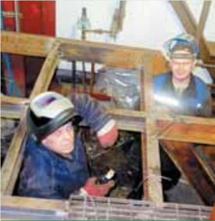
Сварщик ПОРОТЦ Михаил СЕМЕНОВ и слесарь Павел МЕРКУШЕВ выполняют задание по расширению рабочей площадки на печи риформинга.
