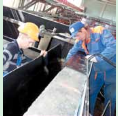
Монтируется установка антикоррозийной защиты на песчаных фильтрах блока деминерализованной воды.
