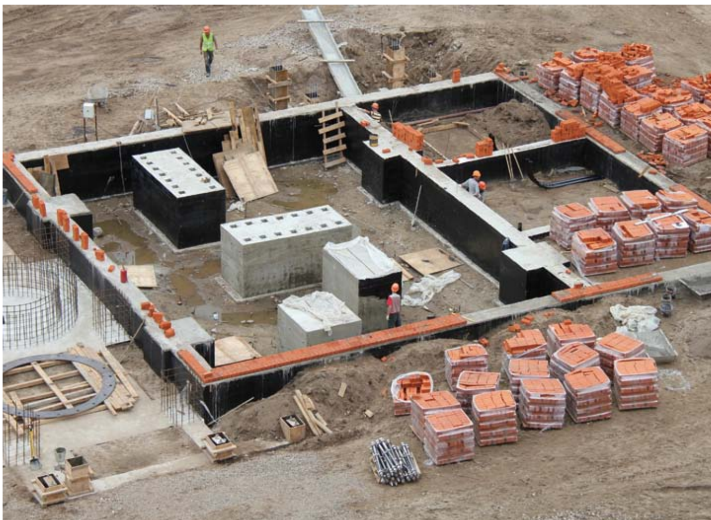
Работы на стройплощадке идут полным ходом.
