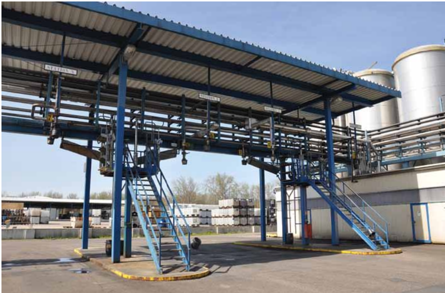
Сливо-наливная эстакада производства смол
