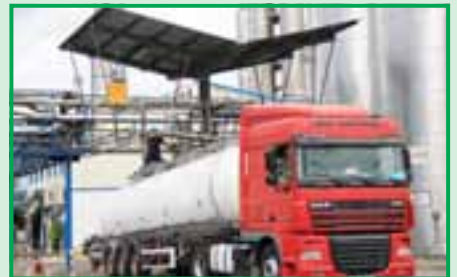
Станция загрузки грузовиков для ДСП-смола
